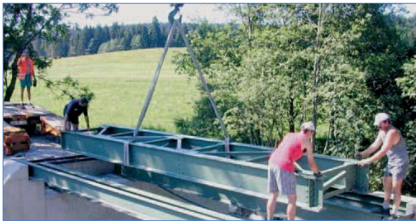
Brückensanierung – Radweg zwischen Roßhaupten und Buching
